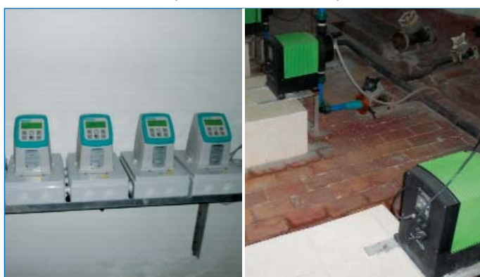
■ Рис. 1. Расходомеры Siemens и дозаторы Alldos Grundfos
