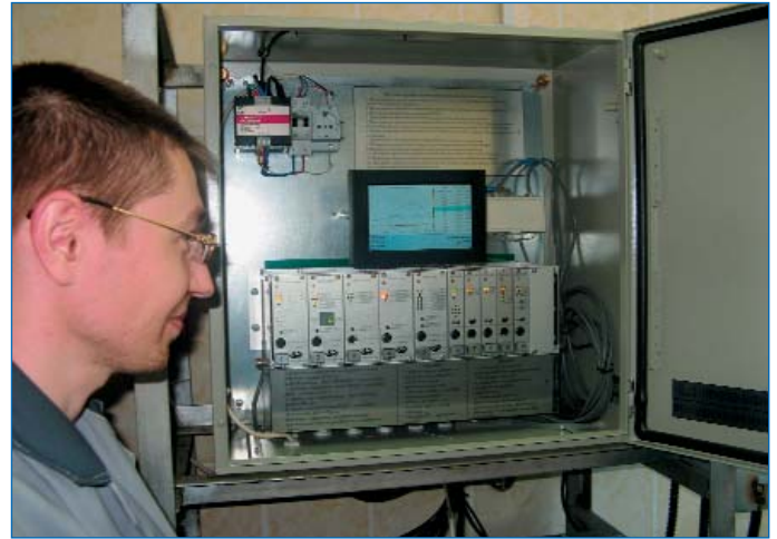
■ Рис. 4. Блок измерения и управления КИМ «Хлор-мониторинг»
